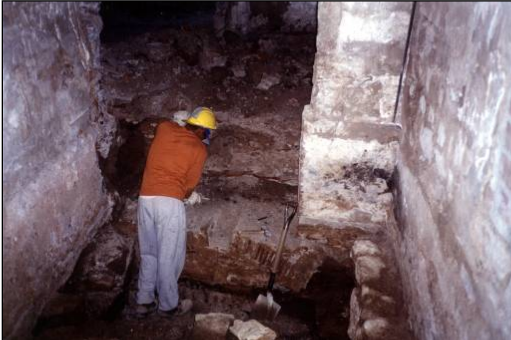
Foto 26. Imatge del procés de desmuntatge del sardinell UE 210.
