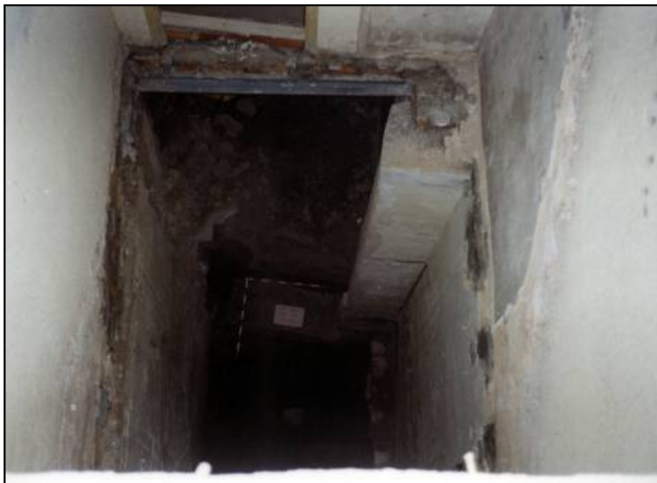
Foto 27. Vista general de l'àrea d'excavació després de desmuntar el sardinell UE 210.
