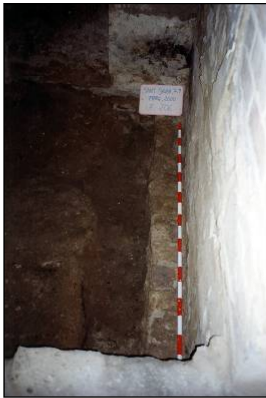
Foto 12. Fotografia de la UE 206, la meitat situada més a la dreta de la imatge és la que quedà fora de l'àrea d'excavació i la que és construïda amb maó massís, la meitat més a l'esquerra és feta de pedres desbastades.
